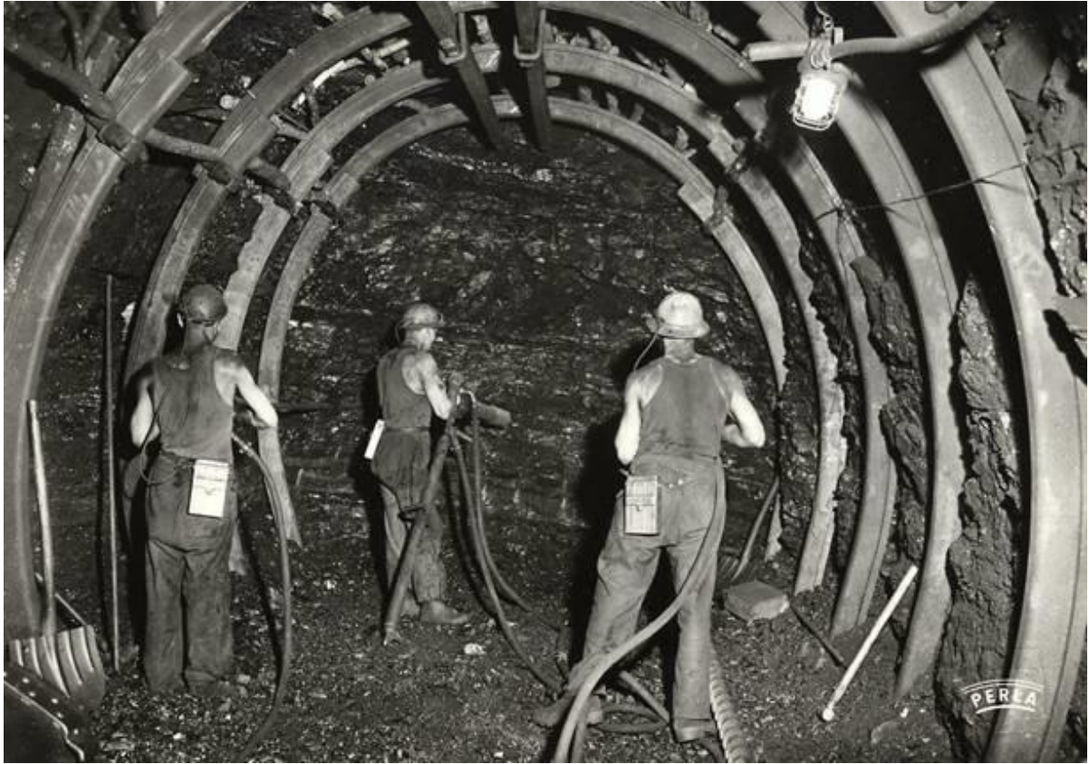
Chantier de traçage au charbon (en voie)
