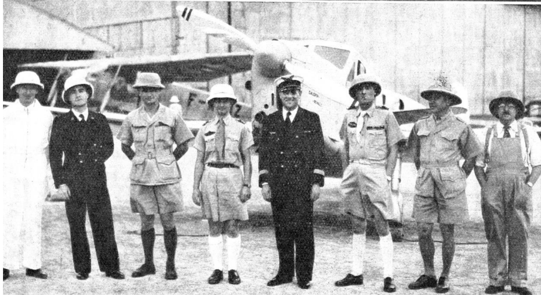
Embarquement du courrier au terrain d'Ivato Vue générale du terrain d'Ivato, l'aérodrome de Tananarive Jean Assollant, au centre, et ses collaborateurs.
