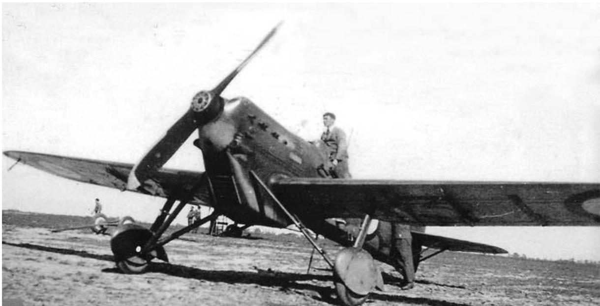
*D.500 remotorisé avec canon tirant au travers de l'hélice.*
