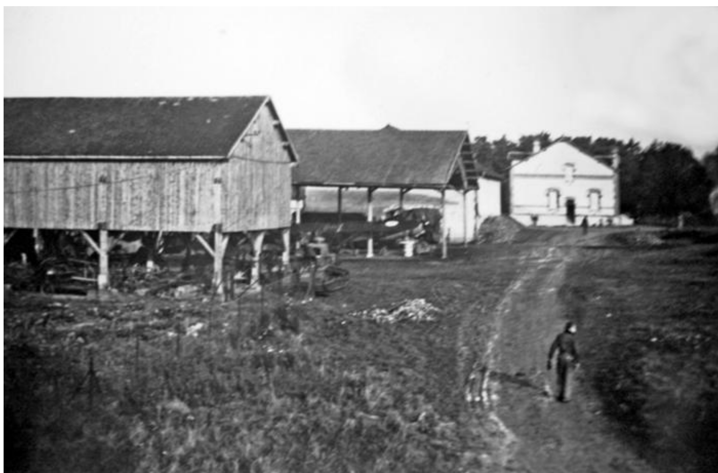
Les appareils du GR I/22 camouflés sous des hangars agricoles Châtel-Chéhéry – Hiver 1939
