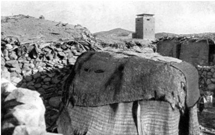
La tour du poste de Dikkil
